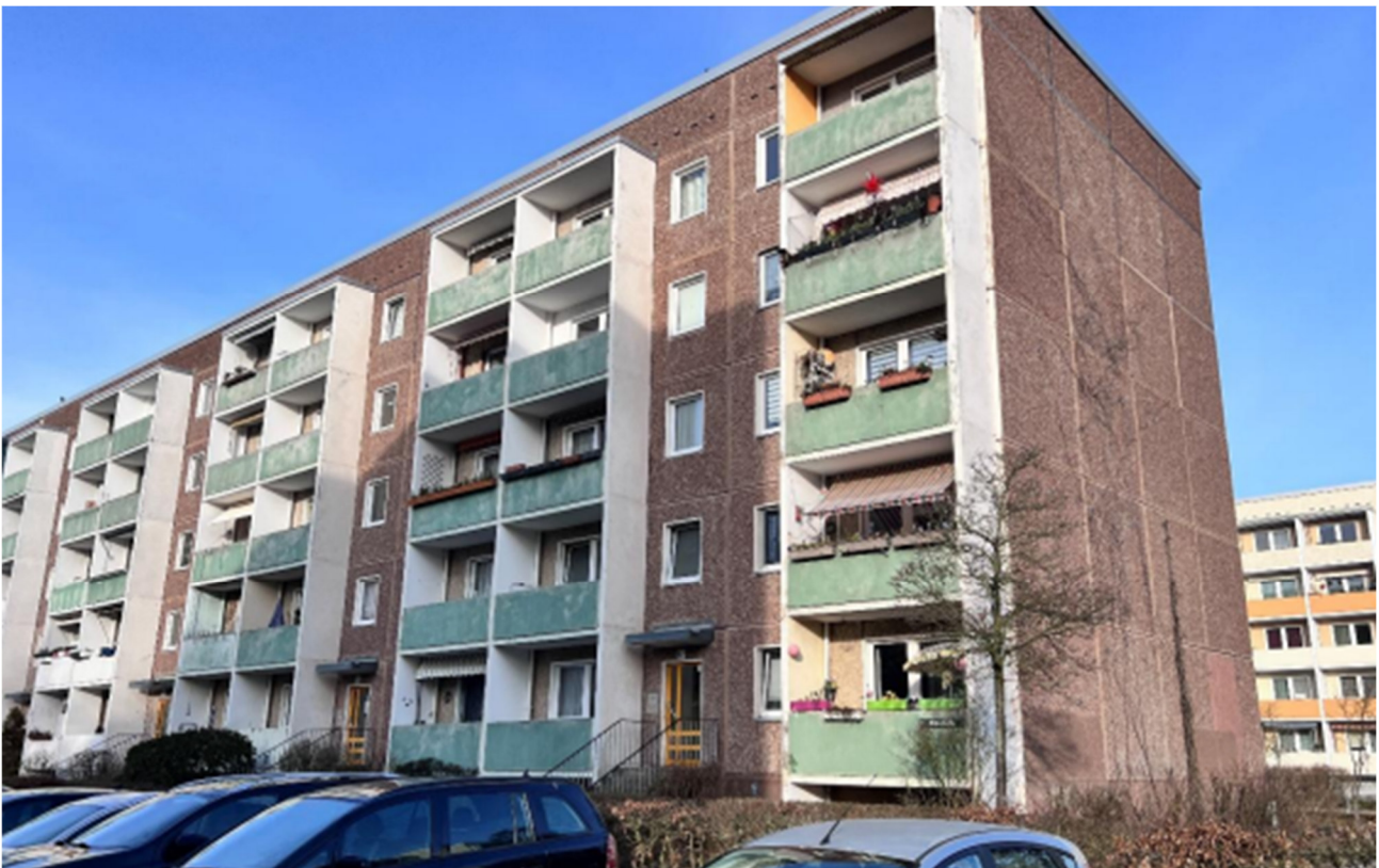
Abbildung 1: Bestandsgebäude Südfassade Biberkiez 31-37u, ProPotsdam GmbH, Fotodokumentation Bestand
